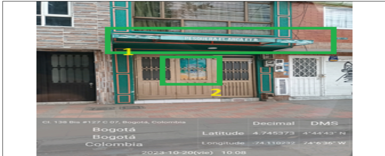
Fotografía panorámica tomada el día 20/10/2023 en el predio ubicado en la CL 139 NO. 127 C – 23 a el elemento no autorizado en carpa identificado con No. 1 y a un (1) elemento no autorizado en ventanas identificado con No. 2
